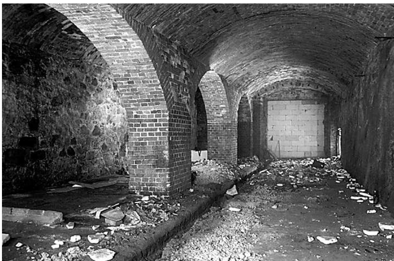
Ryc. 8. Dawny tunel wjazdowy do leżakowni, z pięknymi ceglanymi łukami, wlot jest obecnie zamurowany. Fot. D. Wójcik i K. Krzyżanowski
