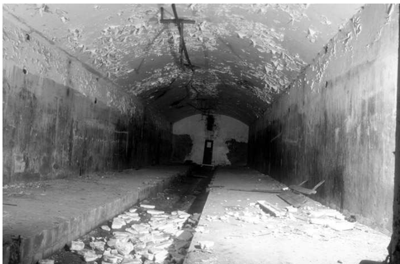
Ryc. 5. Pomieszczenie – chłodnia, o konstrukcji termosu. Stąd można dostać się nad chłodnię oraz do fragmentów podziemi browaru wykutych w skale. Fot. D. Wójcik i K. Krzyżanowski
